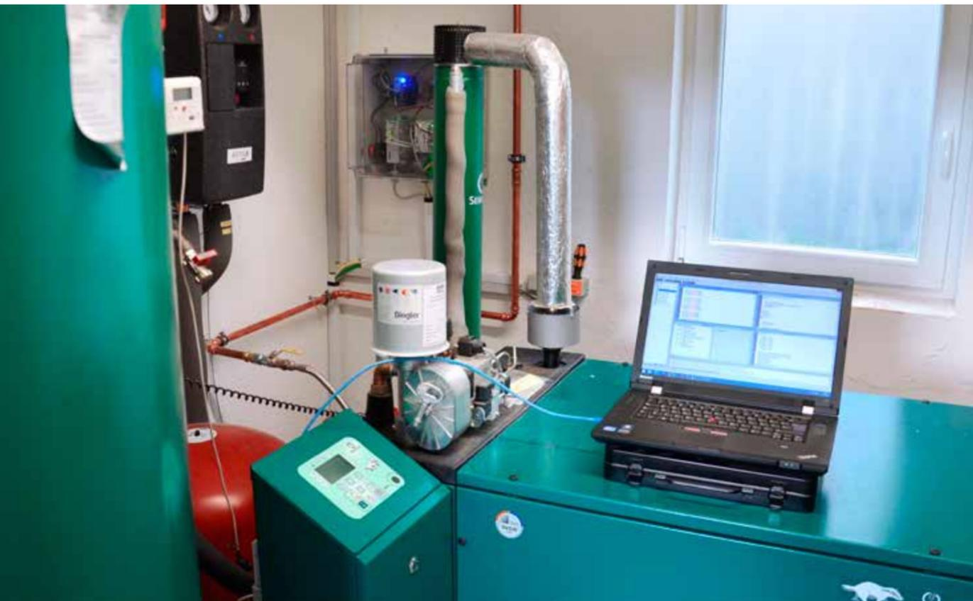
Feldtestanlage mit Blockheizkraftwerk (im Vordergrund), Wärmespeicher (links) und Steuerung (im Hintergrund).
